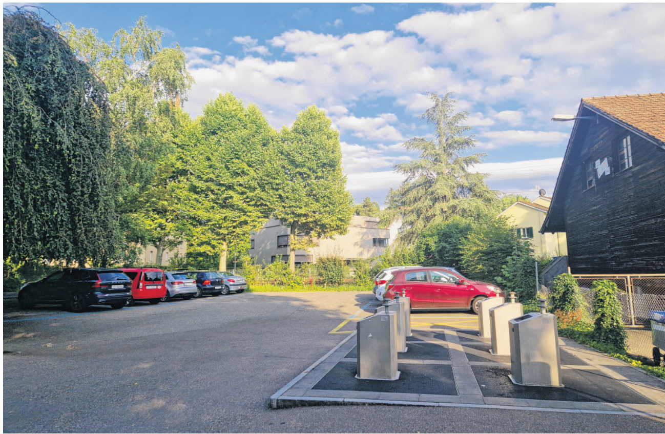
Nach rund drei Jahren mangelhafter Swisscom-Netzabdeckung im Bereich des Bahnhofs wird ab Anfang 2024 eine neue Mobilfunkanlage hier, an der Bahnhofstrasse 61, die Versorgung wiederherstellen.
